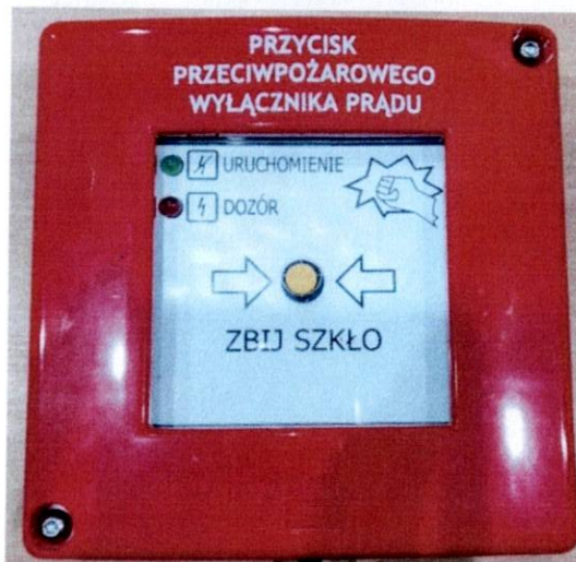
Fot. nr 2. Przycisk przeciwożarowego wyłącznika prądu typu PPWP-A w odmianie PPWP-A D 1/2 K 2Y ZC. Źródło: CNBOP-PIB.
