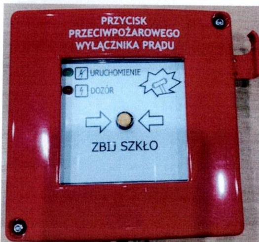
Fot. nr 1. Przycisk przeciwożarowego wyłącznika prądu typu PPWP-A w odmianie PPWP-A M 1/2 K XY ZC. Źródło: CNBOP-PIB.
